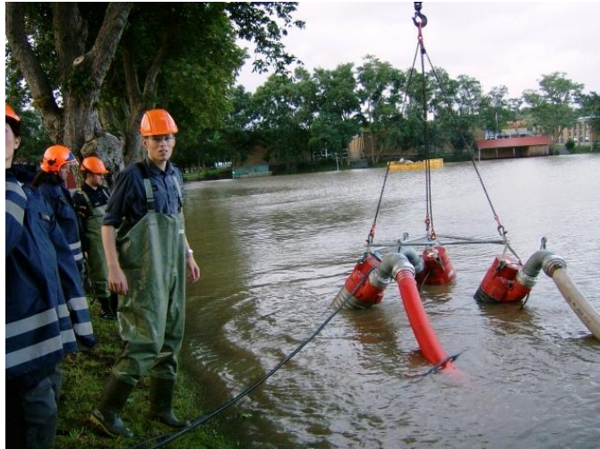
Læsepumper i brug ved oversvømmelse.
