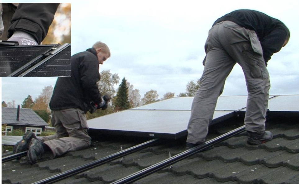
Her ses et eksempel på, hvordan et solcellepanel monteres.
