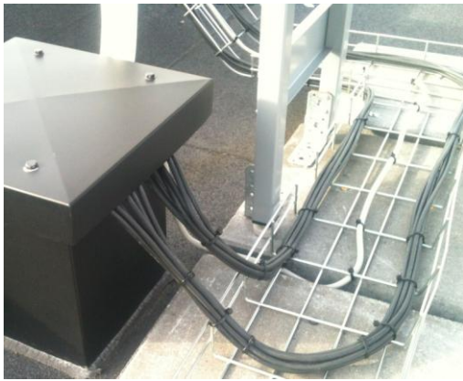
Til venstre ses kabelføring på et fladt tag af ledninger fra et stort anlæg. Til højre ses ledningerne fra panelerne i 6 kW anlæg ført ind under tagkonstruktionen.
