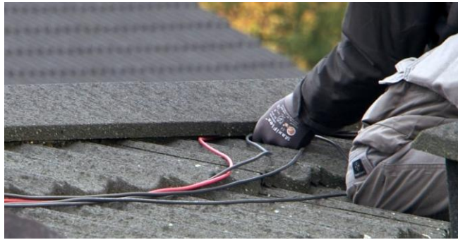
Til venstre ses kabelføring på et fladt tag af ledninger fra et stort anlæg. Til højre ses ledningerne fra panelerne i 6 kW anlæg ført ind under tagkonstruktionen.
